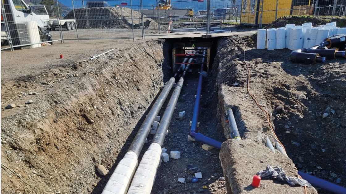
Verbindung Wasserversorgung und Fernwärme Domat/Ems-Tamins © Grünenfelder und Partner AG
